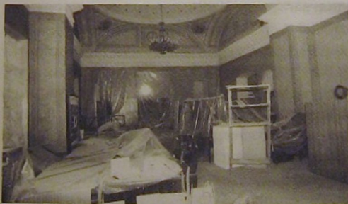
Ремонт в музее, 2002 г.
