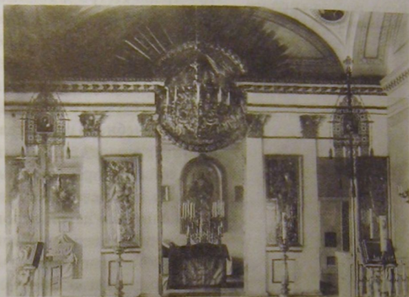
Алтарная часть церкви
